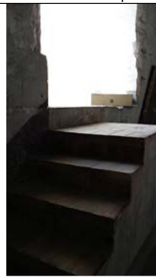
Replà d'escala i finestra a l'exterior
