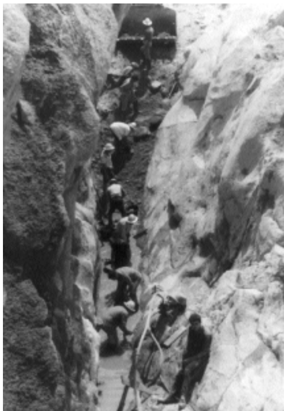
Formigonat de l'esquerda que va quedar al descobert en fer les excavacions pels fonaments de la presa al llit del riu Muga (agost de 1964). Dipòsit: AAEB
